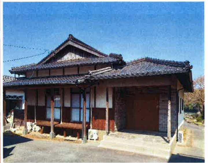
外観は古民家作り
